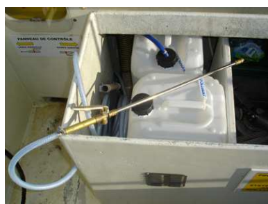
Réservoir de dépolluant d'hydrocarbure
